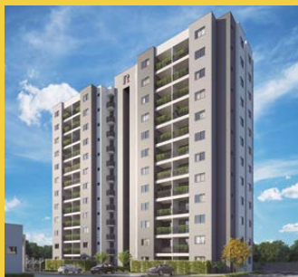
VARANDAS BOA VISTA ANÁPOLIS/GO
